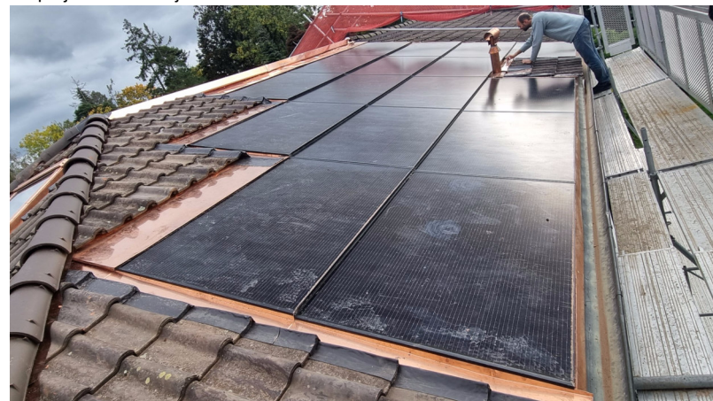
Rénovation de toiture avec intégration des panneaux solaires et récupération de tuiles
