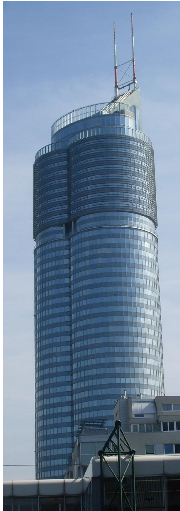
Tour à Vienne au dessus d'une gare.
